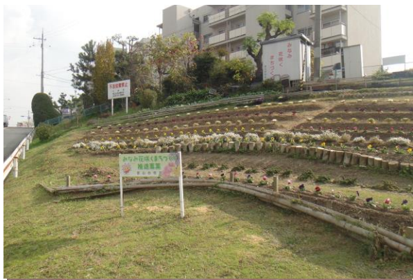
宮山台一丁府営住宅北側法面(点的活動)
