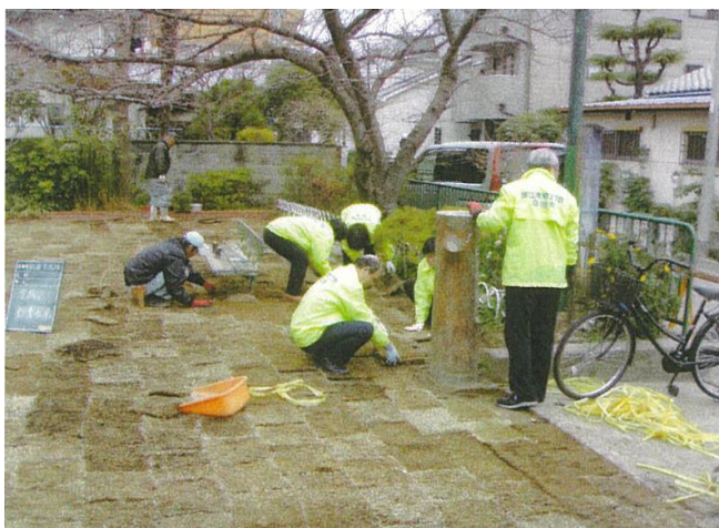
東公園の芝生施工の様子
