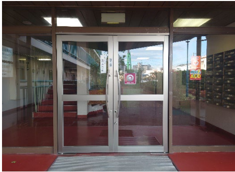
玄関入口 Entrance
