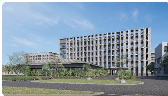
理学部新棟の建設工事 (図はイメージ)
