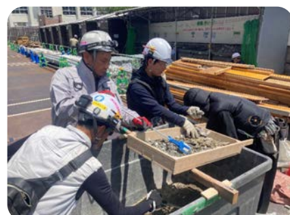
▲ 建設現場で発生した残土を分別
