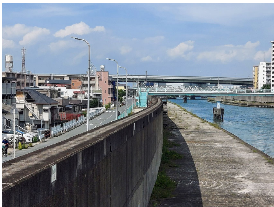
写真 1 大阪市西淀川区の地盤沈下の影響 （川の水面よりも低い場所に住宅が並ぶ）
