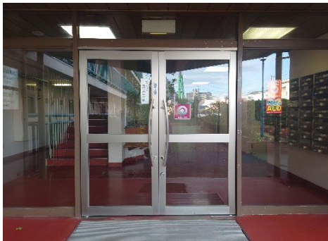
玄関入口 Entrance
