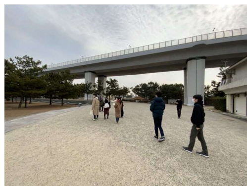
公園と一体開発された阪神高速湾岸線
