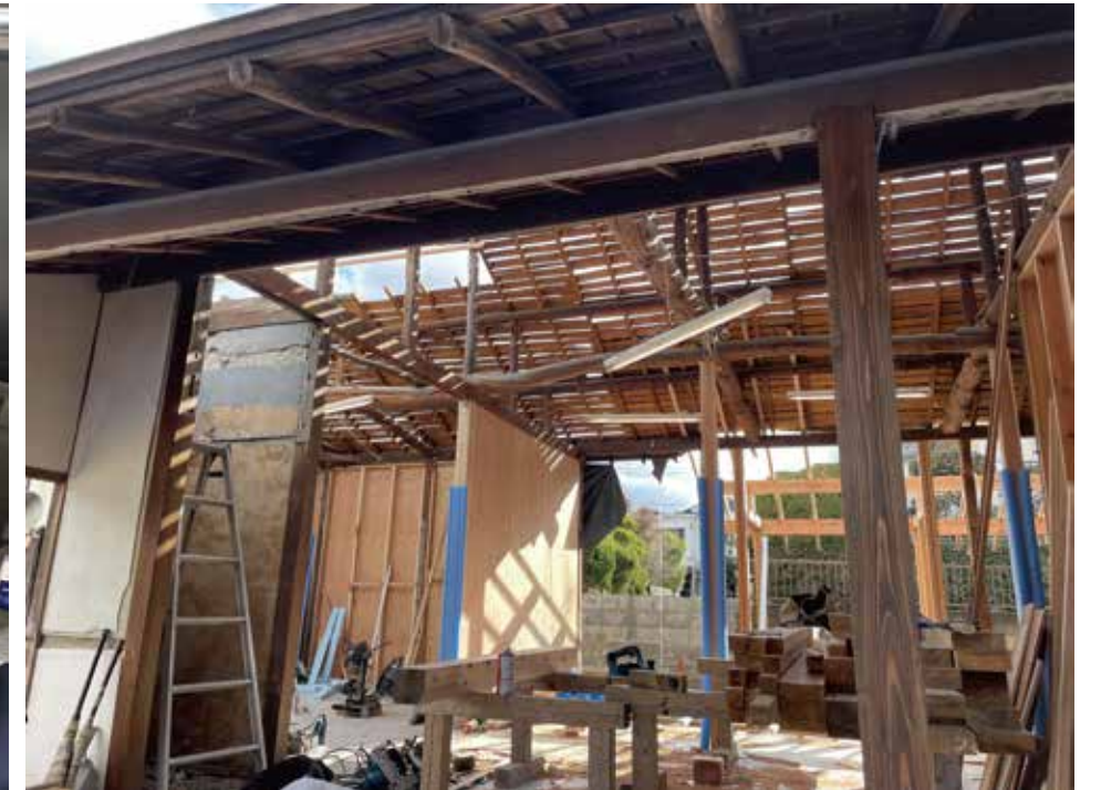
研究室の大工をしている先輩の現場を見せてもらう
