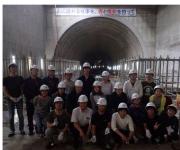
6/29 大和川線工事
