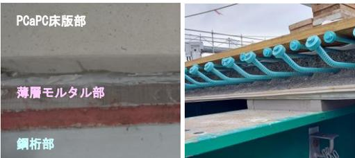
Fig. 2 Thin mortar layer
