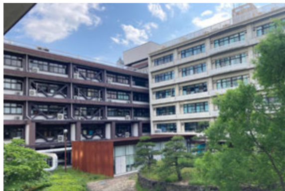
令和 7 年(2025 年)の工学部 B 棟 (白い建物は平成 3 年(1991 年)に建設された F 棟)
