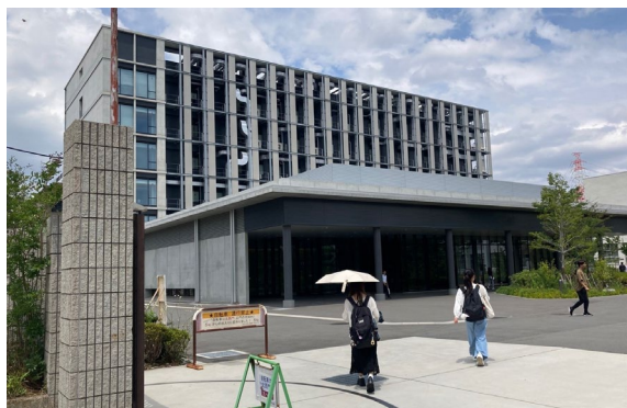
旧教養キャンパス中庭に建設された理学部G棟(6階建て)。1階手前がサイエンスホール。
