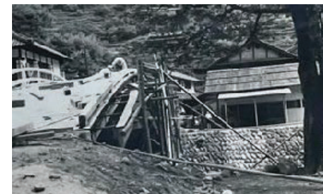
伊勢湾台風の太鼓橋の被害
