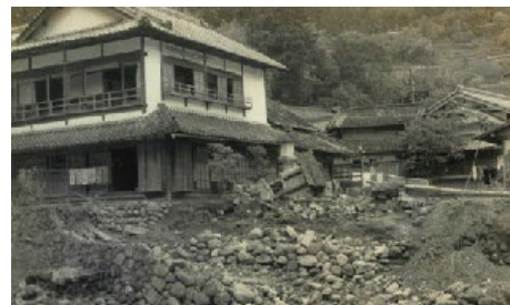
伊勢湾台風の室生川沿いの被害
