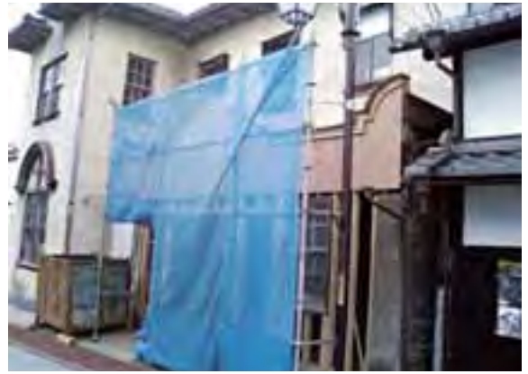
改修中のファサード
