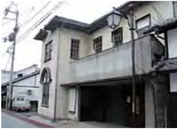
改修前のファサード
