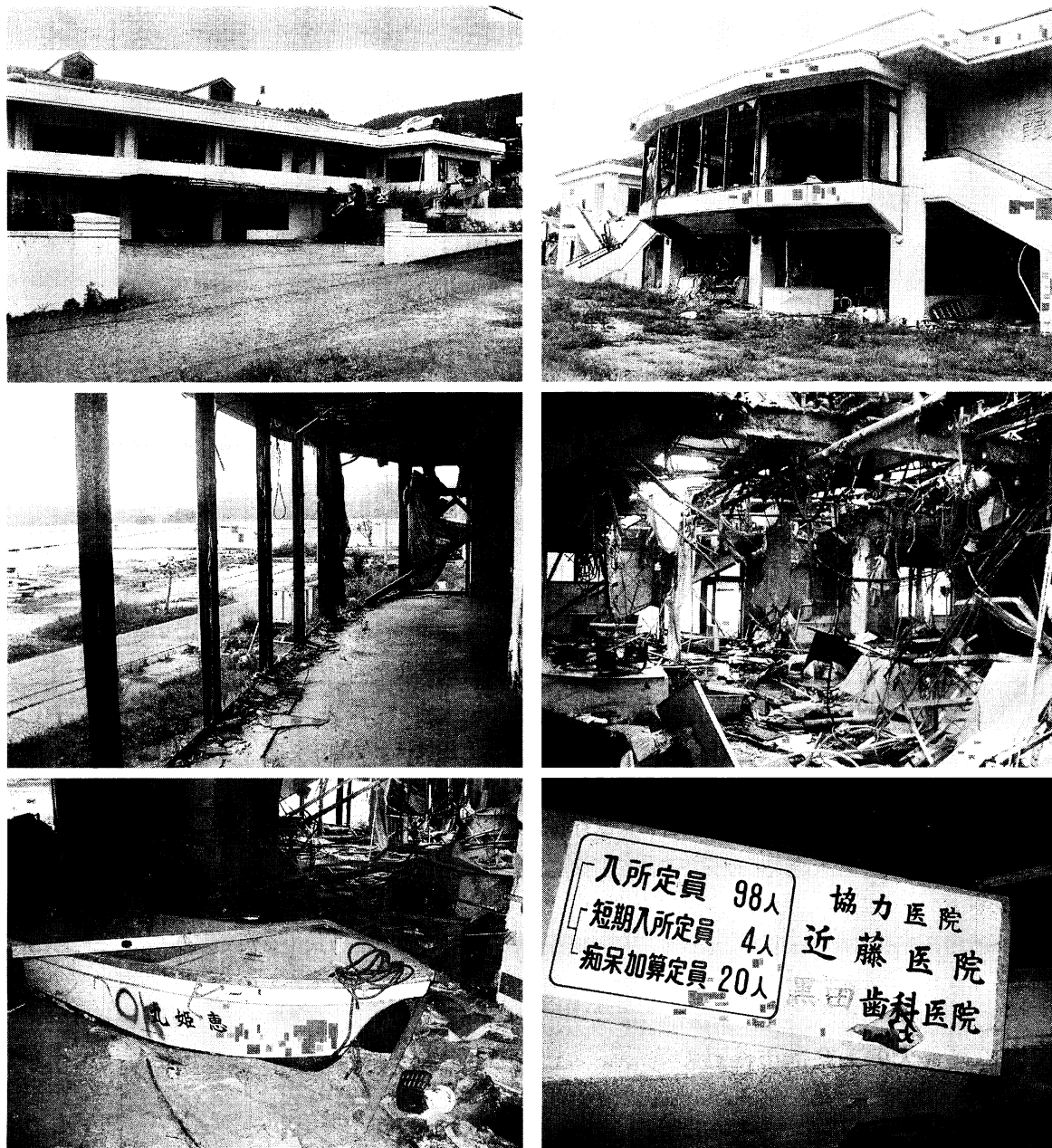
【写真3～8：岩手県山田町の状況】山田湾を望む眺望の良い浦の浜に立地していた老人保健施設「シーサイドから（霞露）」。完全に津波に破壊され、1階に船舶が、屋上にポルシェ車両が打ち上げられている。小長谷2011年8月21日撮影。
