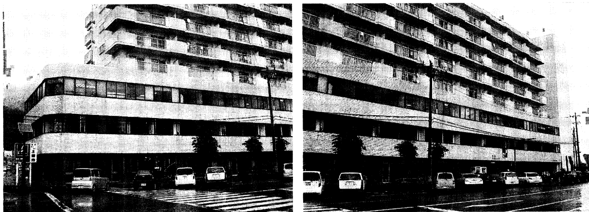
【写真21（左）・22（右）：港湾に近い立地であったが、浸水被害が3階まで限られ4階以上は免れた「市営釜石ビル（浜町1丁目）」小長谷2011年8月22日撮影。
