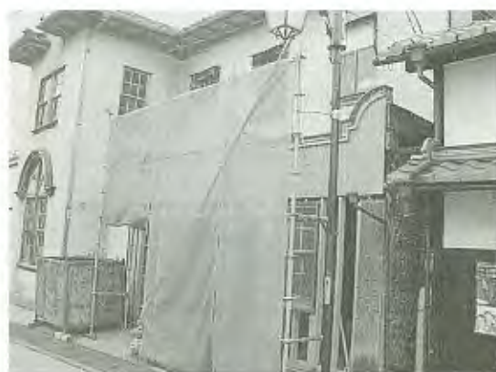
写真12 改修中のファサード
