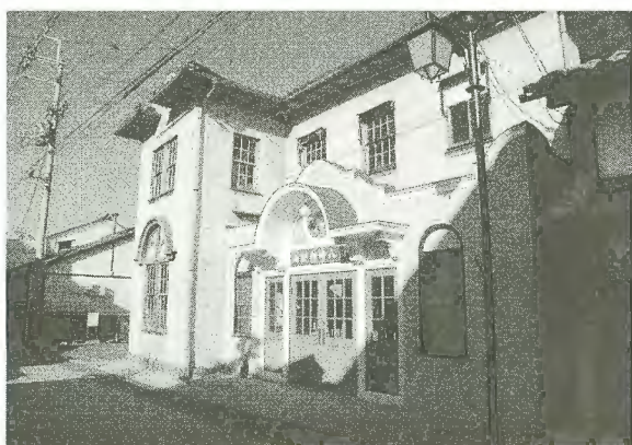
写真13 改修後のファサード
