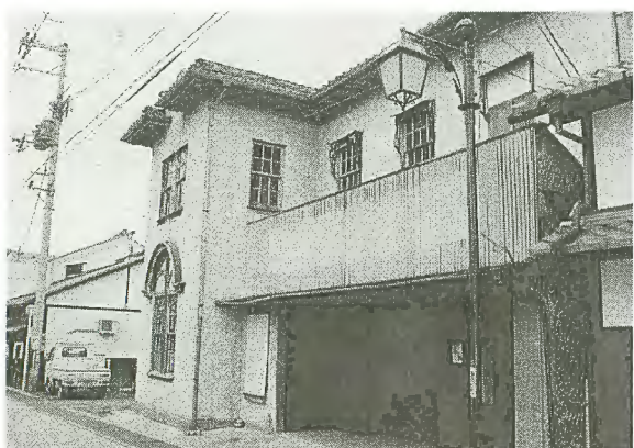
写真11 改修前のファサード
