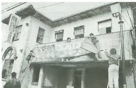
写真7 清掃作業中の状況①
