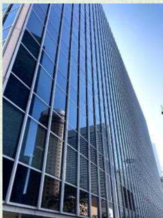
大阪駅前第2ビル
