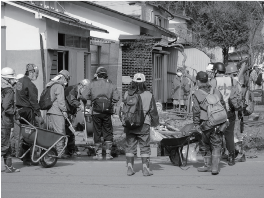
図2 岩手県大槌町での家屋の泥だし作業
