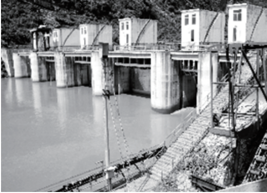
図7 雲南省の小型水力発電所
