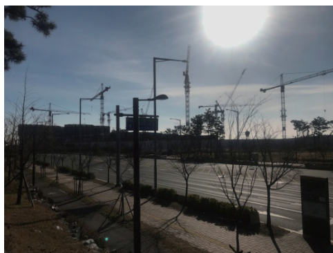
飯場近所の建設現場
