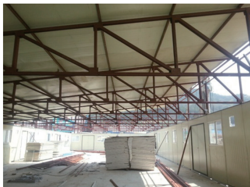
仮設建物飯場の工事
