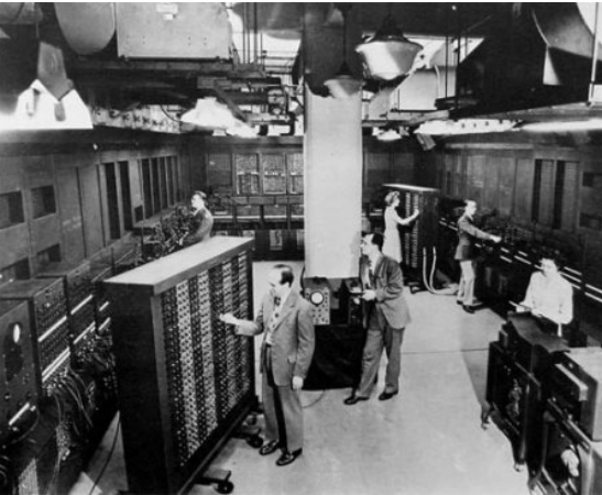
チューリング完全電子計算機ENIAC(1946年) 真空管17,468本・総重量27 t・底面積167 m 2 部屋全体がコンピュータ
