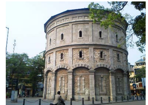
給水塔 (フランスによる建造物)
