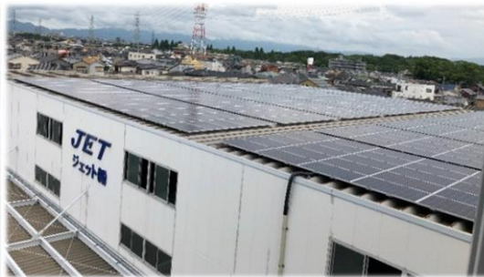
再生可能エネルギー 屋上太陽光パネル
