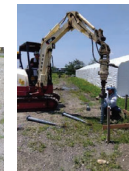
鋼管杭打設
