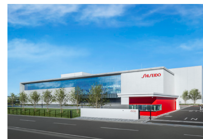
資生堂久留米工場生産設備 (2022年竣工)
