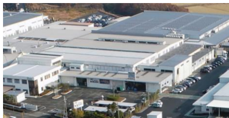
本社第一工場
