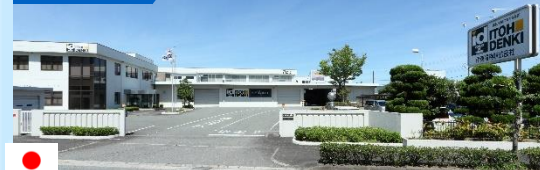
■本社第一工場
