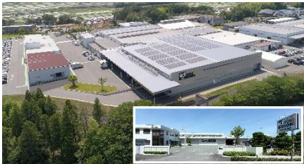
本社第一工場
