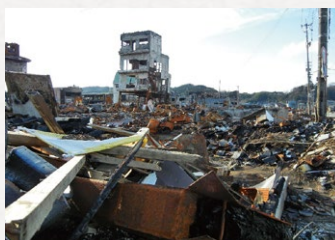
朝市通り火災現場(輪島市河井町)
