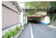
3 高架下のトンネルを通過する。
