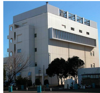
低線量影響実験棟
