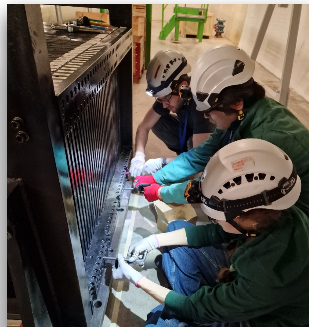
2026/01@CERN LHCトンネルでの組み立て
