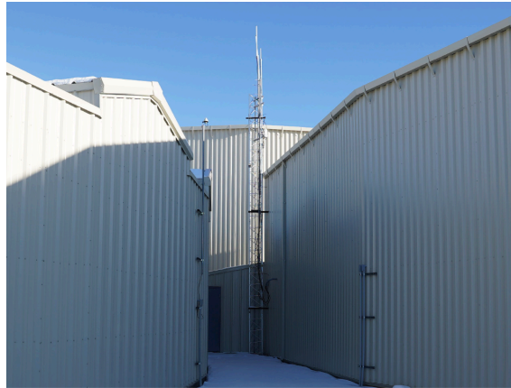
図 2.6: TALE-infill SD アレイ用のデータ通信塔 [1]。中央に写る鉄塔の頂点に取り付けてあるのが無指向性アンテナ、中腹にある白い箱がアクセスポイントである。右手前の建物が TA MD、奥の建物が TALE FD である。
