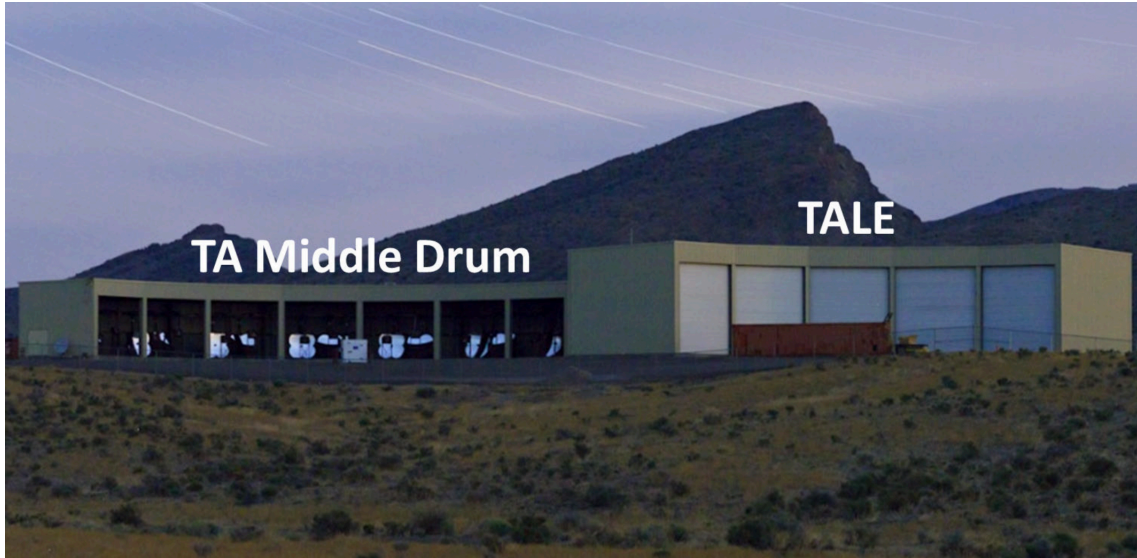
図 2.9: TA FD の MD ステーションと TALE-FD ステーションの外観 [9]。
