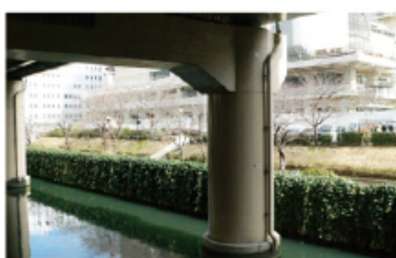
→シティプラザ大阪建設中
