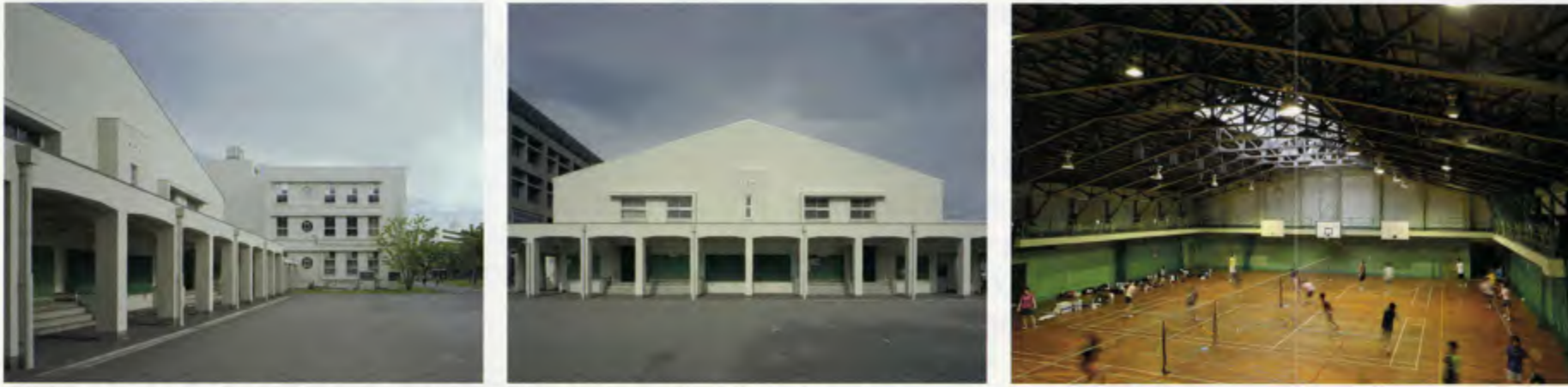
写真左:左手に体育館、正面に2号館。2つの建物は柱廊でつながれている。写真中:体育館正面。写真右:体育館内部。鉄でトラスが組まれている。
